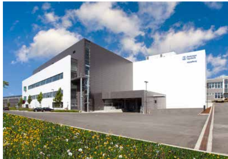
Durch einen Anbau wird die bestehende Zerstäuberfabrik im TPDO um das Modul 3 erweitert.
